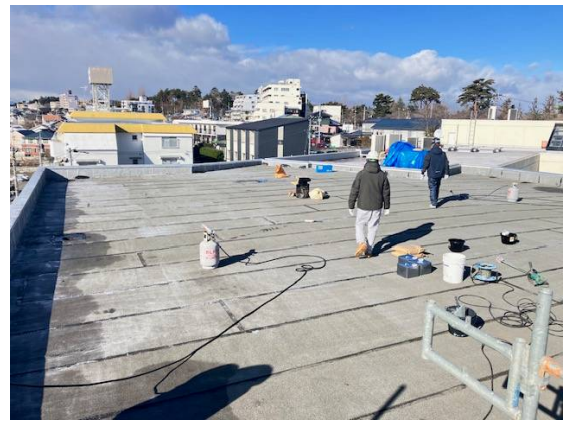
8 号館屋上防水改修
