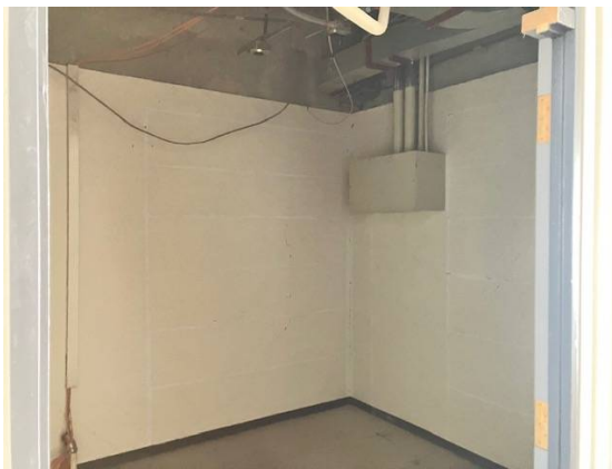
3 号館トイレ改修 内装解体
